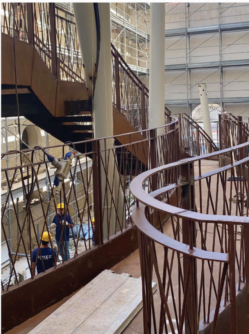
Scala in acciaio corten saldato trasversalmente con vetro in cristallo. Università di Sassari
